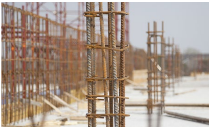
Udine lavori di costruzione della Casa dello Studente (Rizzi)
