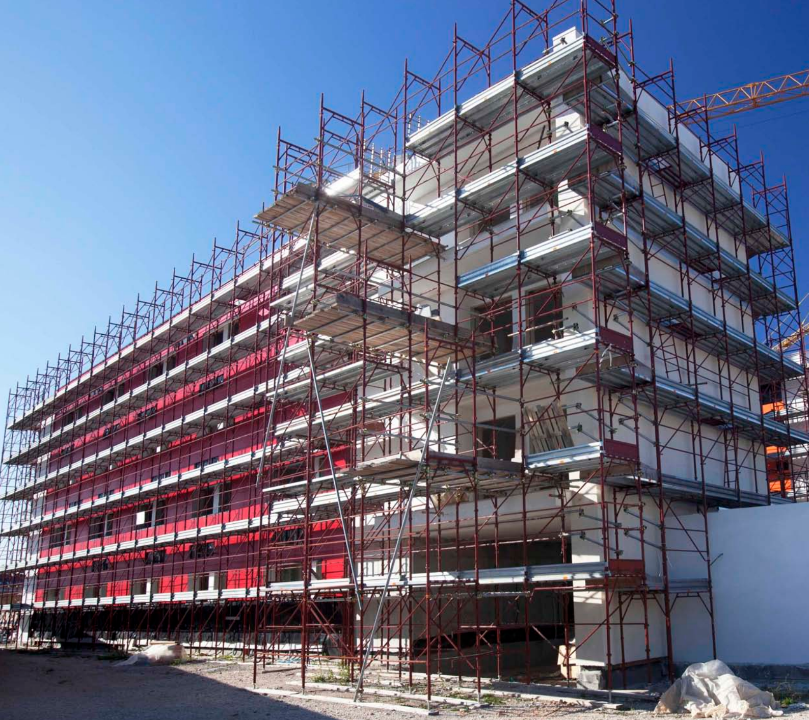
Udine - Polo Universitario dei Rizzi Cantiere Nuova Casa dello Studente
