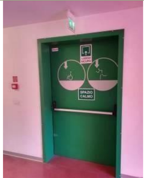
Identificazione uscita di sicurezza di piano e via di accesso allo spazio calmo
