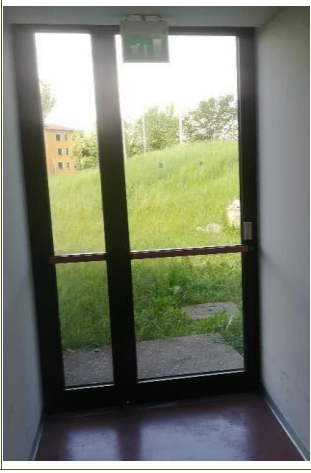
PIANO TERRA Scala di emergenza lato Nord Ovest
